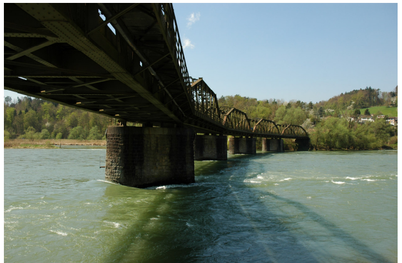
Fotos: Eisenbahnbrücke Felsenau
